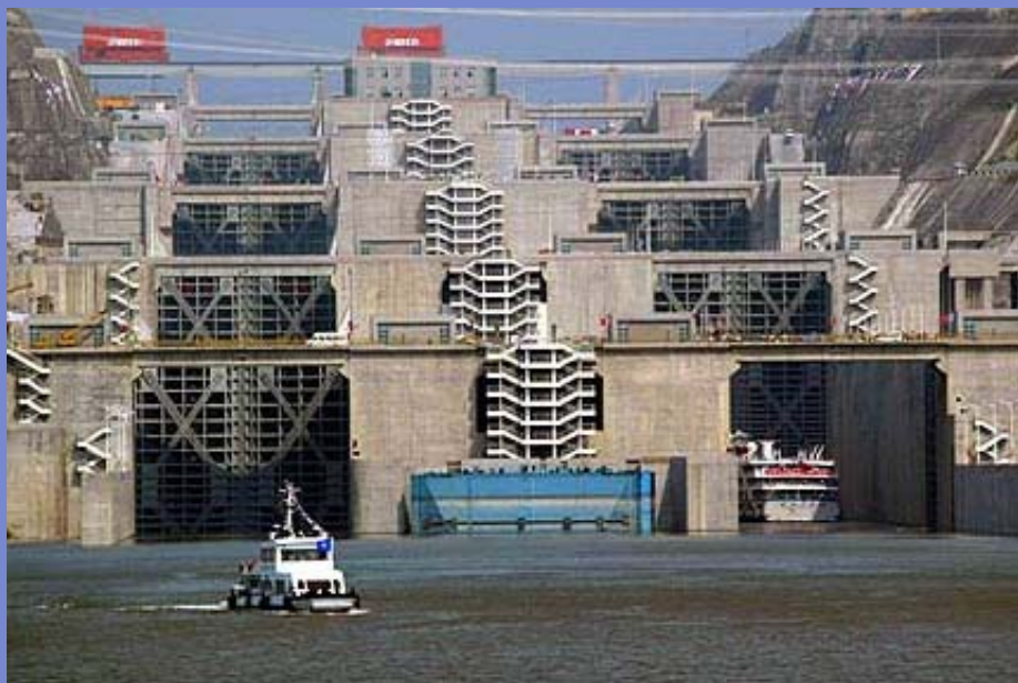
13套西门子S7-417H冗余控制系统分别对双线5级船闸的12个闸首进行安全可靠控制
