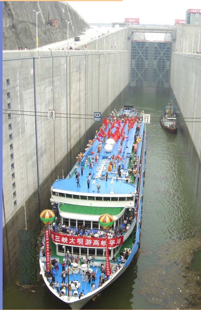
西门子公司为三峡永久船闸系统提供安全、可靠和先进的自动化技术，确保了船闸于 2003 年 6 月顺利通航。
