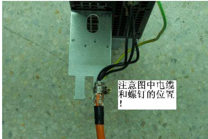
图2-6 屏蔽板安装及电缆连接示例
