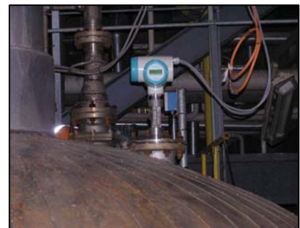
图四：Sitrans LR400 在 DV2 装置上的使用
