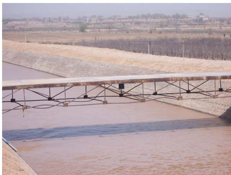
系统于 2006 年 6 月投用，通过对流速测量的现场试验，测量数据稳定，跟踪性好，测量结果满足用户要求。把所测的各参量输入到中央管理控制器，可以实现对各渠流量的实时监测，控制以及对流量趋势的长达 24 个月的纪录。通过此测量方法实现了灌溉应用中分配水量，水量计量以及水头损失的计算，大
