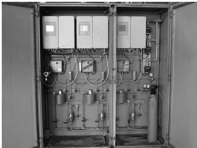
图 2 西门子 Oxyamat 6 氧分析仪用于齐鲁石化苯乙烯装置尾气氧含量监测：全套系统
