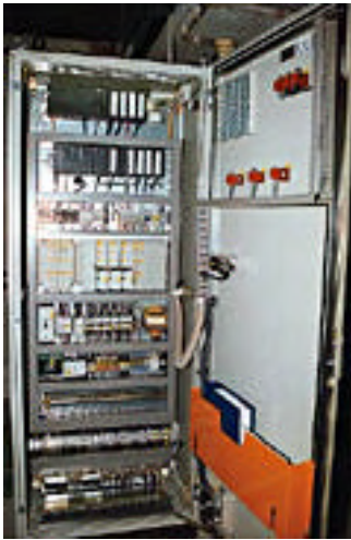
在测量范围内，记录三个力的任务由两个SIWAREX M功能模块执行。
