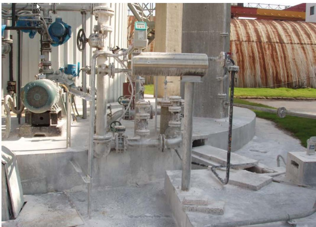
这种安装的关键就是流量计出口到吸收塔的压力要比从主管分支到流量计入口的压力要小，这样才能有浆液流动，并且可以很方便的控制流量和进行清洗。
