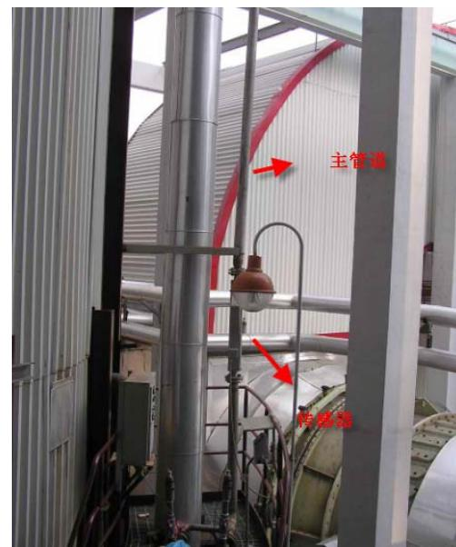
这也是错误的安装；这种错误主要因为简单的加了旁路后，介质并不能通过流量计，因为流体的流动是要靠压差来实现的，这么短的管道,加上流量计本身的压损，流量入口和出口并没有足够的压差来实现流动。因此对于测量和清洗来说,都是困难的。
